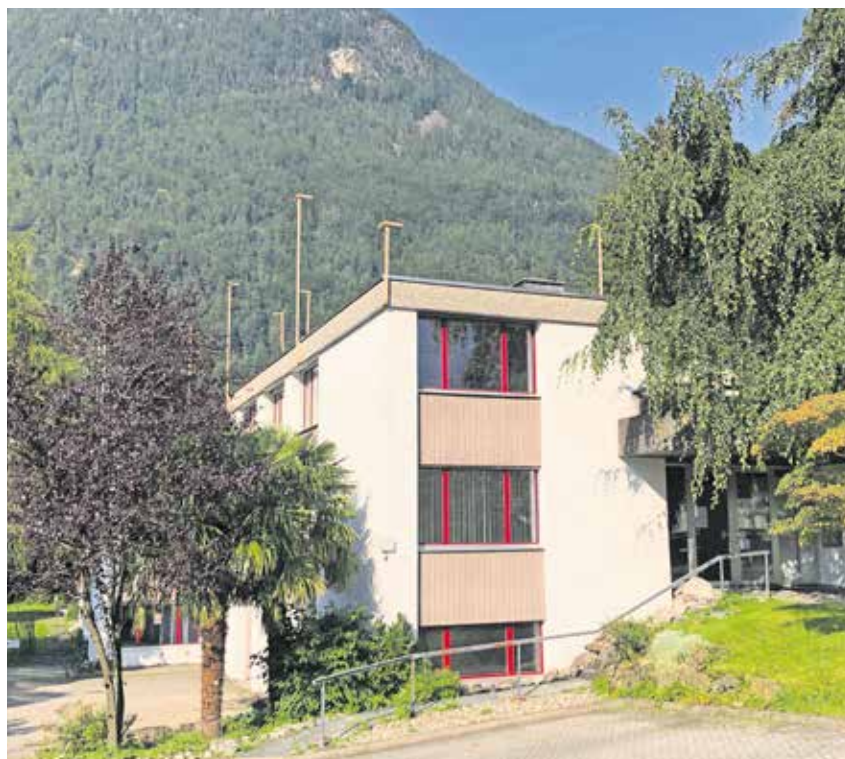
Die Liegenschaft an der Seedorferstrasse erhält einen Aufbau mit zwei Attikawohnungen und einen Lift. FOTOS: HEIRI ARNOLD
